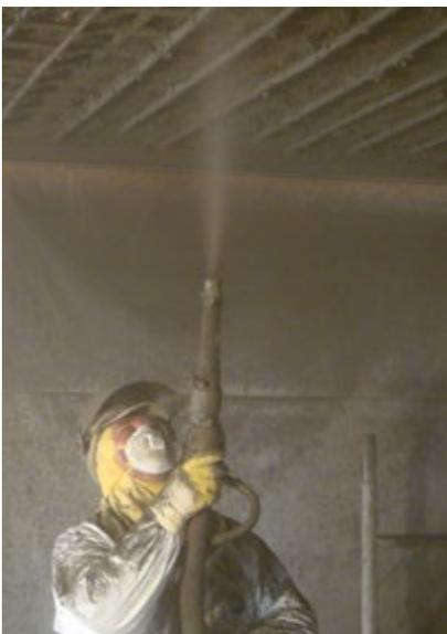
Pour des travaux de réparations de béton y compris sous charges dynamiques.
