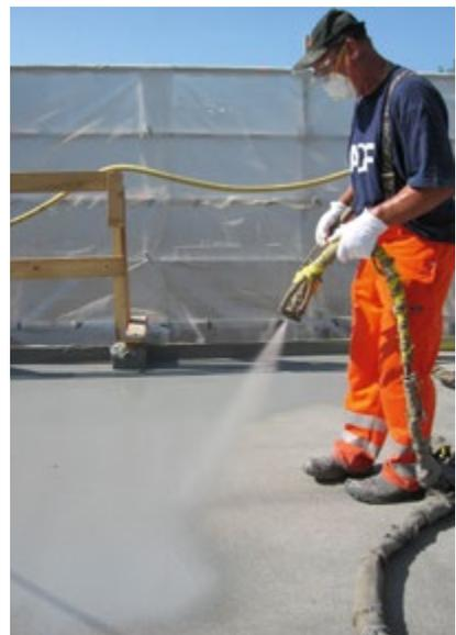
Pour une protection durable contre les fissures de tabliers de pont
