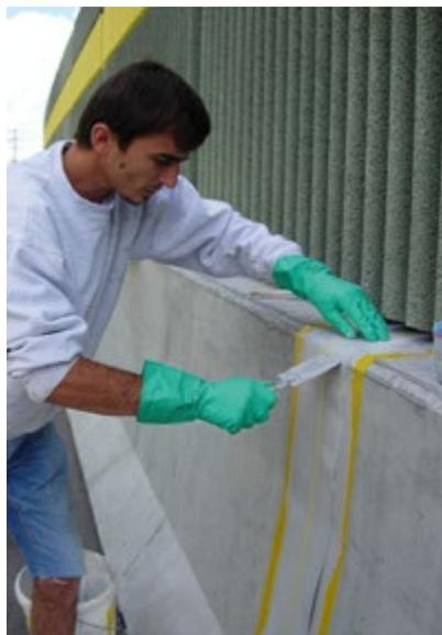
Pour un scellement imperméable de tous les types de déformations et de joints de construction.
