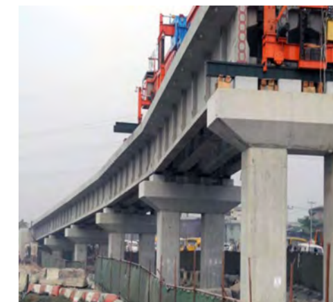
Maitre d'ouvrage: Administration des transports de la zone métropolitaine de Lagos (LAMATA) Entrepreneur: China Civil Engineering Construction Corporation (CCECC)
